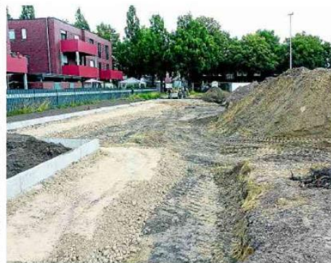
Die Randsteine sind bereits gesetzt, hier entstehen Parkplätze für die fertiggestellte Sporthalle.
