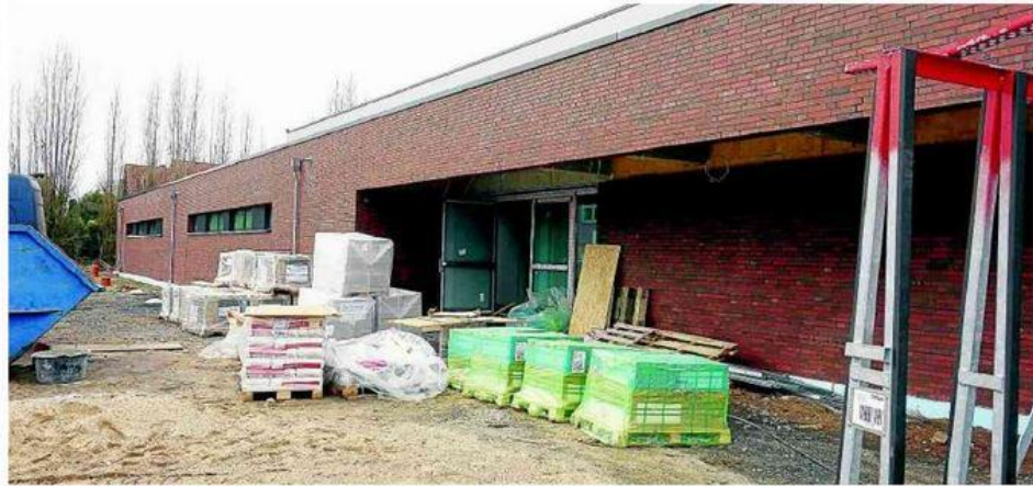
Mittlerweile ist die Sporthalle an der Käthe fast fertig – aktuell werden noch Arbeiten an den Außenanlagen durchgeführt.
