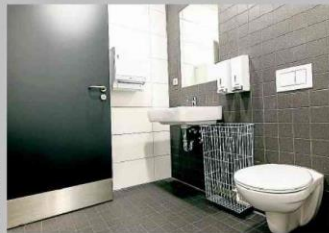
Die Sanitäranlagen und Duschen entsprechen modernen Standards.
