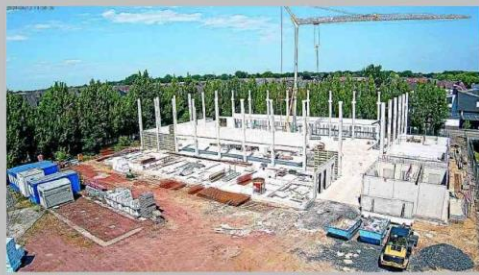
Noch vor einem Jahr war nur wenig von der schmucken neuen Halle an der Käthe-Kollwitz-Schule zu erkennen. Nun wurde das Gebäude im Zeit- und Finanzrahmen fertiggestellt und steht nach dem Sommerferien für den Sportunterricht der Schule zur Verfügung. Foto: Stadt Emsdetten
